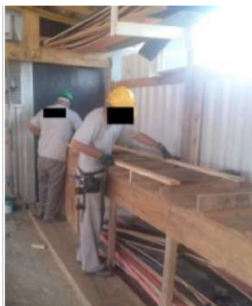
Figura 1: Fabricação de formas de madeira na carpintaria.
