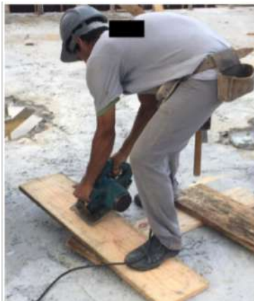
Figura 2: Corte de tábua na construtora.
