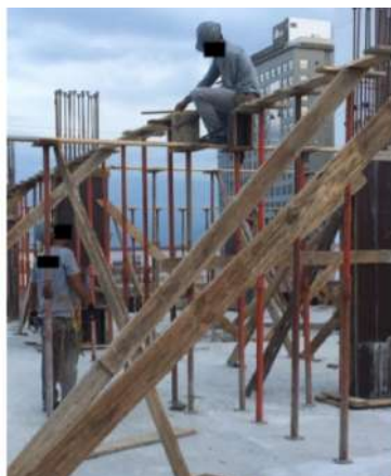
Figura 3: Montagem de formas.
