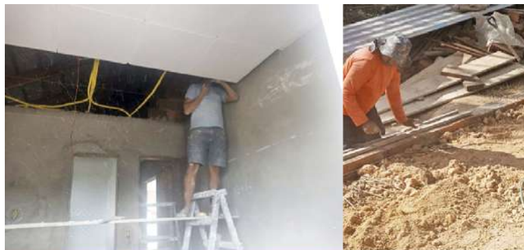
Figura 1 – Trabalhador em andaime e trabalhador exposto a pregos
