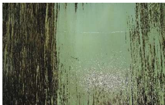
Figura 2 – Parede interna do tanque após aplicação do produto isento de BTXE
