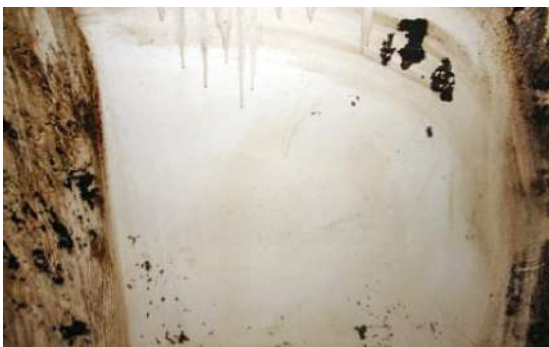
Figura 3 – Parede interna do tanque pós uso do querosene
